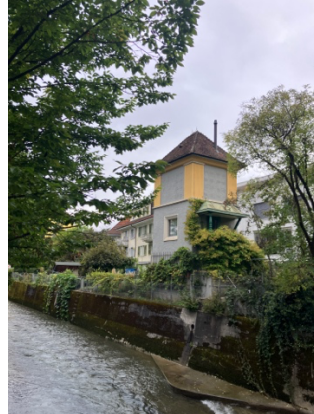
Transformatorhaus (Jugendstil), Olten
